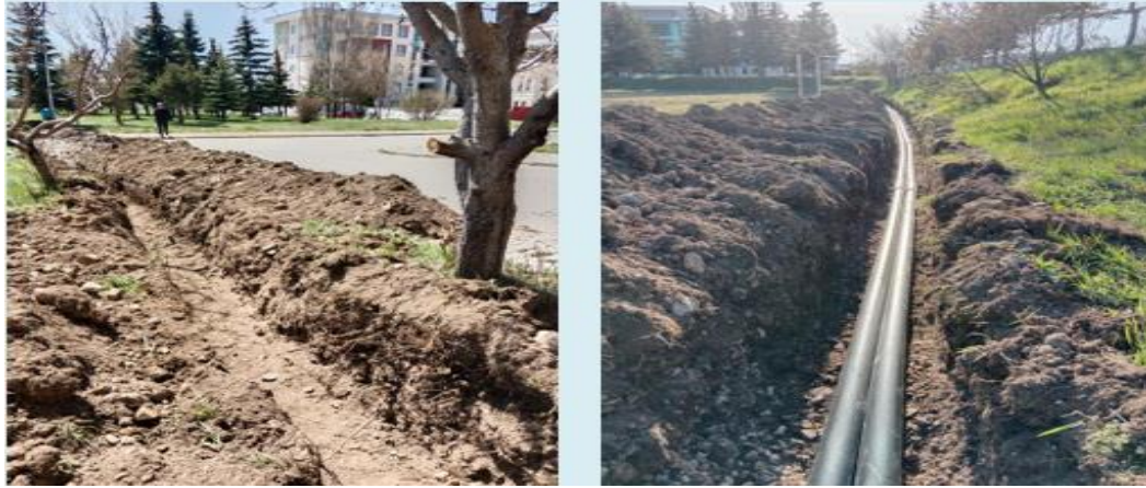
Kampüs Altyapısı projesi kapsamında yapılan bazı işler
